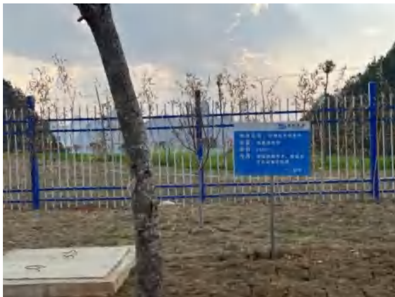
图 4-3 厂区初期雨水池（300m 3 ）
