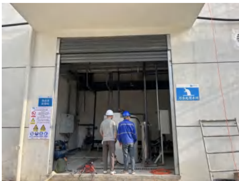
图 4-1 渗滤液处理站
